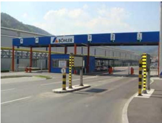
Böhler – Portale di monitoraggio radioattività
